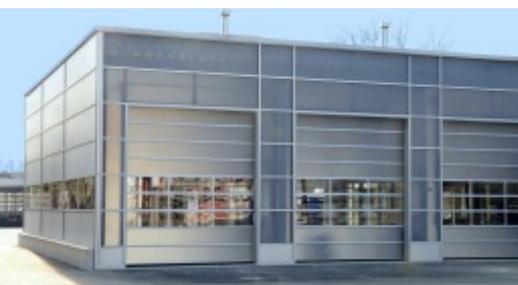
Auch für den Werkstatt- und Waschhallenbereich eignet sich das Hubtor mit seiner vorteilhaften Technik. Statt Echt-Glas kommt hier das lichtdurchlässige Butzbach Fiberglas bei den Toren und Fassaden zum Einsatz.
