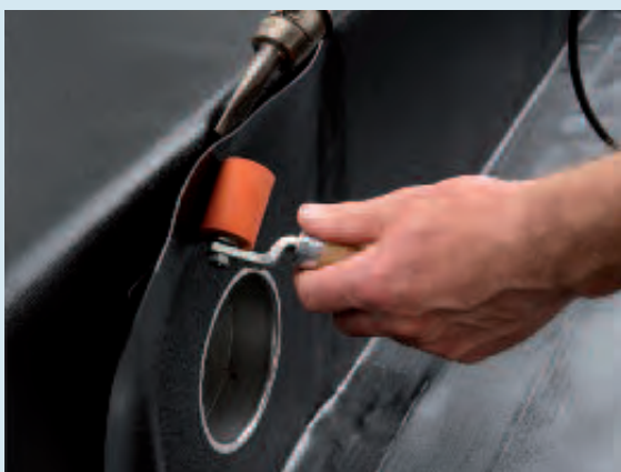
Anschluss mit Bahnenflansch an die Attikaabdichtung
