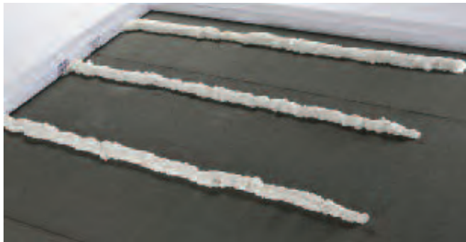
Klebstoff als Raupe auftragen . . .
