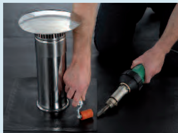
Anschluss an die Flächenabdichtung
