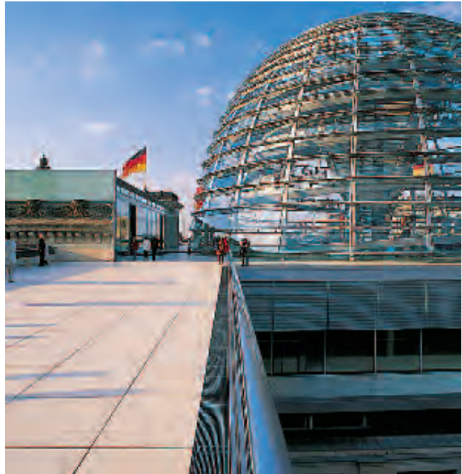
Sicher abgedichtet mit dem WOLFIN PYE-System: Das Dach vom Reichstag in Berlin.
