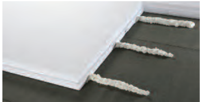
. . . Dämmstoff einlegen und festdrücken – fertig.
