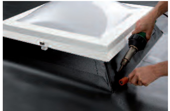
WOLFEN Edelstahl-Verbundbleche als Lichtkuppelanschluss
