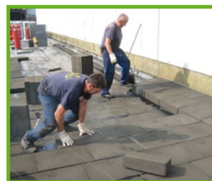
2: Einbau der Schaumglas Dämmschicht
