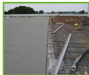
6: Aufbringen des bewehrten Schutzbetons auf PE-Gleitlagen
