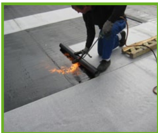
3: Zweite Lage: Abdichtung aus WOLFIN IB/G 2,0 mm
