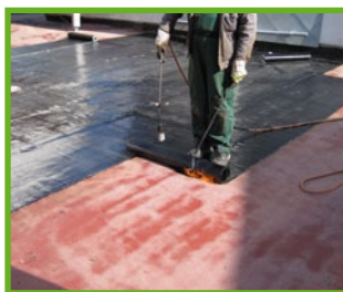
2: Erste Lage: Abdichtung aus PYE-PV-200 S5
