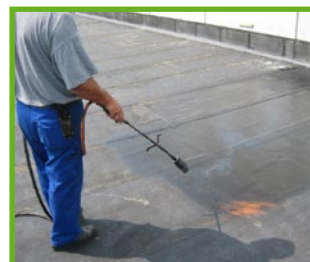
4: Vorbereitung für die Verklebung der WOLFIN GWSK
