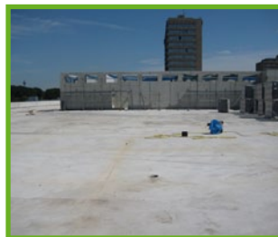
7: Fertige Betonschutzschicht
