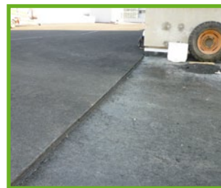
6: Schutz- und Nutzschticht aus Gussasphalt
