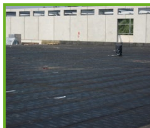
3: Erste Lage der Abdichtung mit PYE-PV-200 S5
