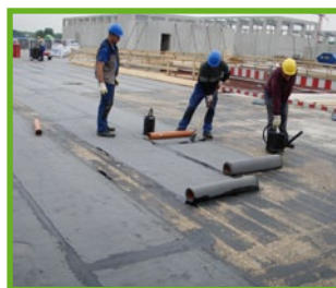
1: Notabdichtung mit Bitumenbahn im Gieß- und Einrollverfahren
