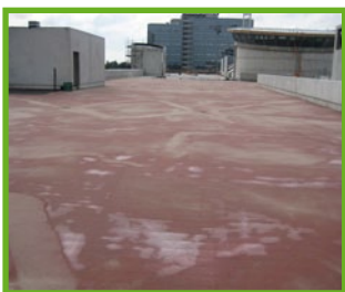
1: Epoxidharzbeschichtung als Feuchtigkeitssperre
