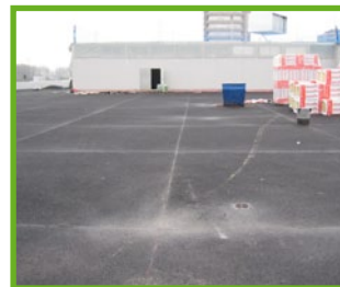
8: Fertige Nutzschticht aus Gussasphalt
