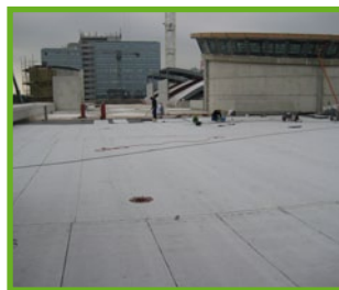
5: Fertig abgedichtete Fläche vor dem Aufbringen des Gussasphalts
