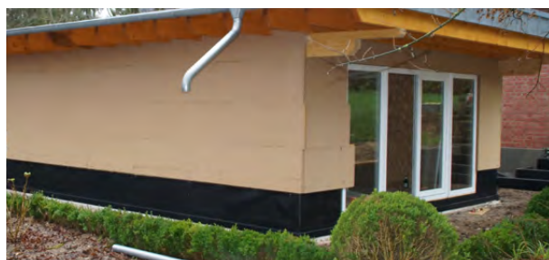
Abdichtung für Bodenplatte und Sockelbereich
