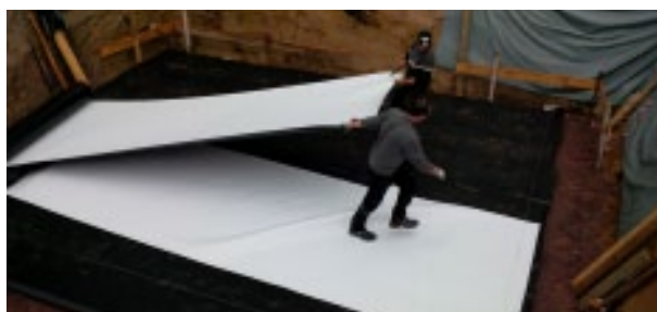
Rissüberbrückende Abdichtung für Bodenplatte und Sockelbereich
