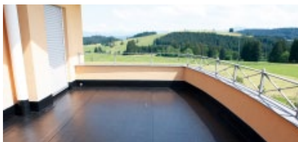
Terrassen- und Balkonabdichtung
