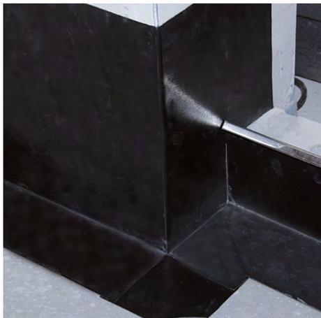
**1** Im ersten Schritt wird auf dem verlegereifen Untergrund (Fließestrich) ein WITEC-Schutzvlies als Trenn- und Schutzlage ausgelegt und für die Wände werden WOLFIN-Edelstahl-Verbundblechelemente zugeschnitten und gekantet. Als Mindestanschlusshöhe gilt 15 Zentimeter über Oberkante Nutzbelag (letzte Schicht).
