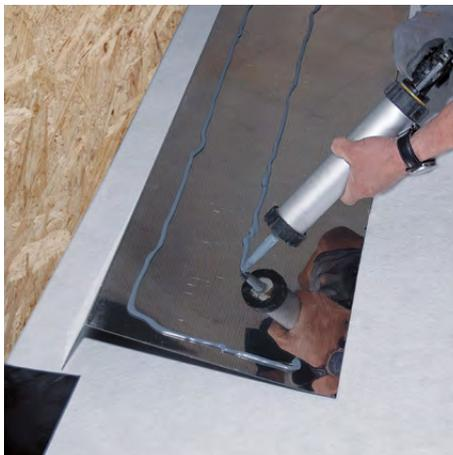
**2** Zur Befestigung wird rückseitig der WOLFINATOR Montageklebstoff aufgebracht. So verklebt müssen die Edelstahl-Verbundbleche i.d.R. nur an den Profilen mit Dübeln und Schrauben mechanisch fixiert werden. Die Profilstöße werden mit einem Krepband abgeklebt, mit WOLFIN IB-Streifen abgedeckt und auf dem Verbundblech mittels Heißluft verschweißt.
