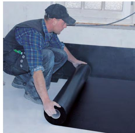
**3** Danach wird als Dichtungsbahn WOLFIN IB ausgerollt, ausgerichtet und die Nähte in der Fläche und an den aufgehenden Bauteilen werden homogen verschweißt.
