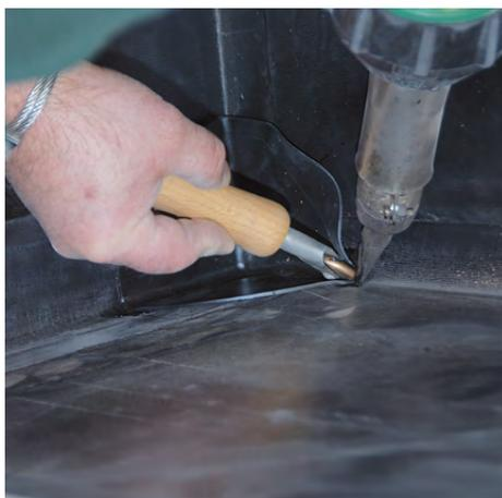
**4** An allen Detailpunkten wie Profilstößen und Ecken wird der homogene Anschluss der WOLFIN-Bahnen an die Verbundblechelemente mit dem Heißluftfön durchgeführt. An den Innen- und Außenecken empfiehlt es sich, vorgefertigte WOLFIN-Formteile zu verwenden.
