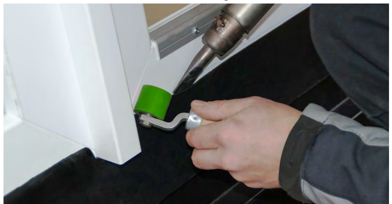
Wasserdichter und sicherer Anschluss an PVC-Tür- und Fensterelemente mittels Heißluft.
