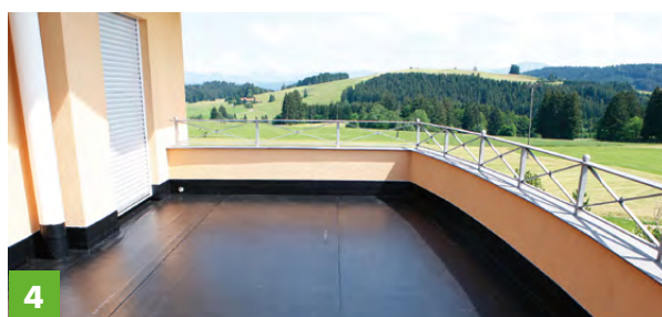
Terrassen- und Balkonabdichtung
