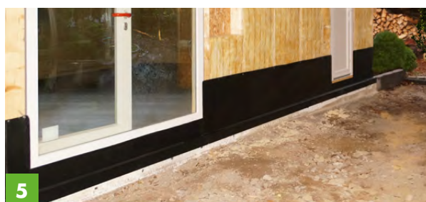
Rissüberbrückende Abdichtung für Bodenplatte und Sockelbereich
