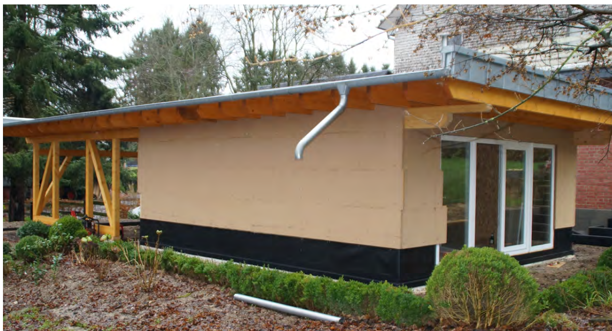
Sockelabdichtung mit WOLFIN IB
