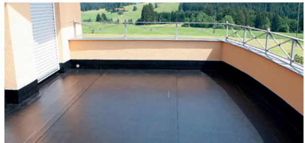
Terrassen- und Balkonabdichtung 4
