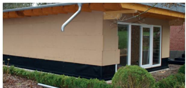
Abdichtung für Bodenplatte und Sockelbereich 5
