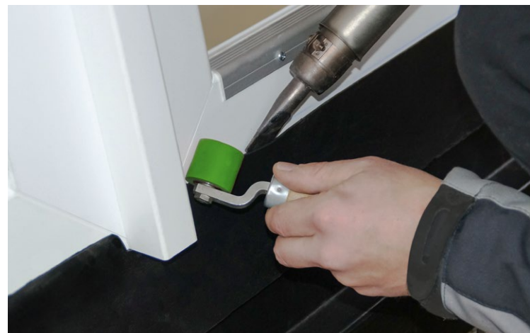
Wasserdichter und sicherer Anschluss an PVC-Tür- und Fensterelemente mittels Heißluft.
