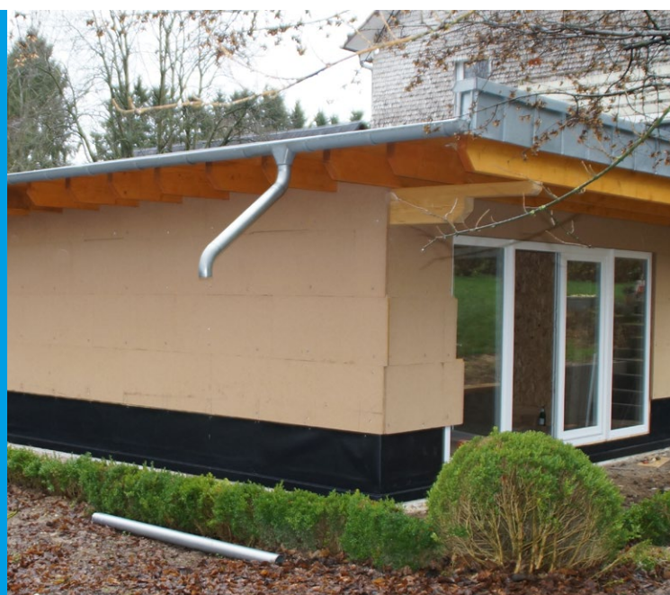
Sockelabdichtung mit Wolfin IB.
