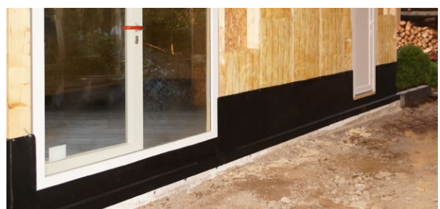
Rissüberbrückende Abdichtung für Bodenplatte und Sockelbereich 5
