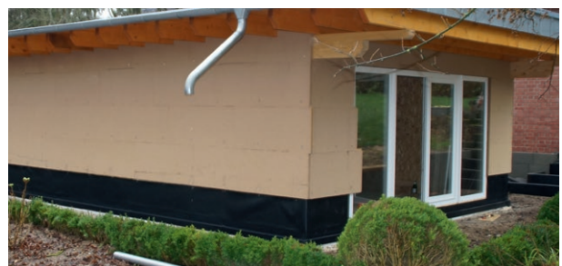
Abdichtung für Bodenplatte und Sockelbereich
