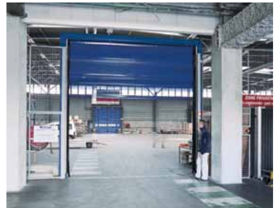
Automatisches Schnellaufitor, Hangar, LYS
