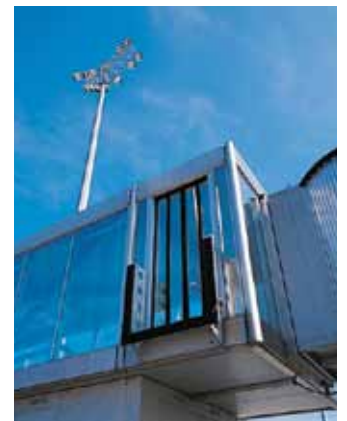
Automatische Falttür, Fingerdock, CDG
