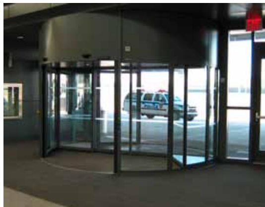
2-flügelige Karusselltür mit integrierter automatischer Schiebetür, JFK
