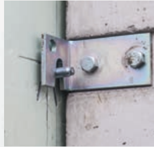
Einhängen des Lichtschachts an die Dübel
