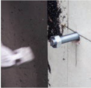
Schwerlastdübel bis zur Hälfte in Betonwand einschlagen
