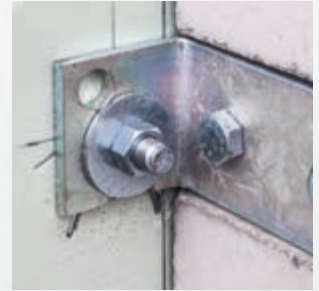
Anschließend alle Muttern wechselseitig vollständig festziehen
