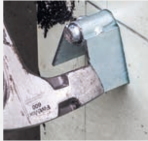
Einschlagen des Befestigungselements
