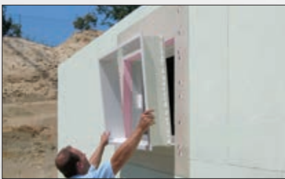
Einfache Montage des Perimeter-Abdeckrahmens
