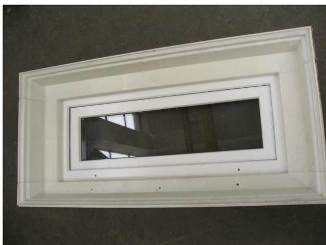
5. Zwischenraum außen zwischen Fenstereinsatz und Zarge abdichten (alternativ Dichtmasse vor dem Einbau des Flügels auf die Zarge/ Blendrahmen auftragen)
