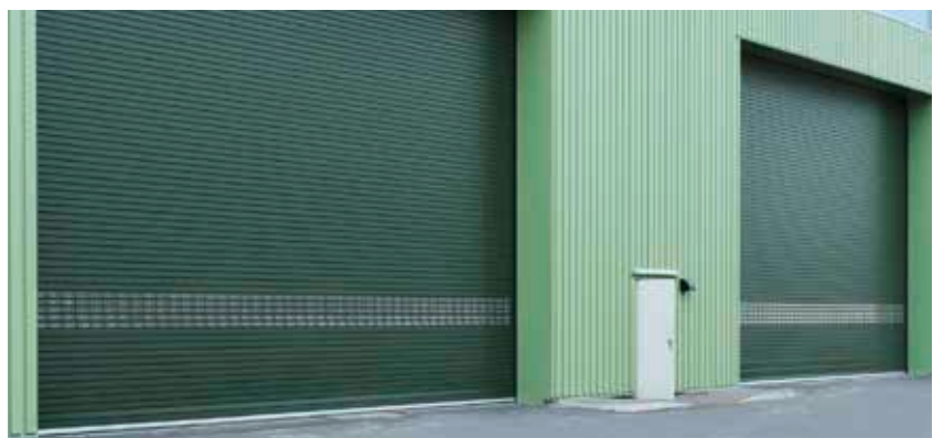
Hallenabschluss in einem Industriebetrieb
