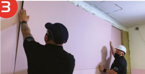
Schließen Sie die Trennwand mit dem gewünschten Trockenbaupanel gemäß der Empfehlung des Herstellers.
