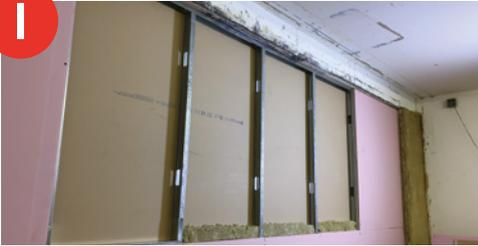
**FZ100** wird in der Regel während der Trockenbauphase installiert. Eine Seite der Trennwand kann bereits vor dem Einbau von **FZ100** fertiggestellt werden.
