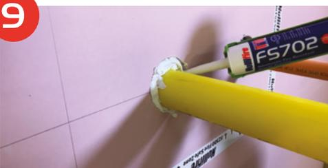
Auf beiden Seiten der Trennwand ist eine Kaltrauchabdichtung notwendig. Wir empfehlen die Verwendung von Nullifire FS702 Acryldichtstoff (bitte lesen Sie für diese Anwendung im technischen Merkblatt zu FS702).
