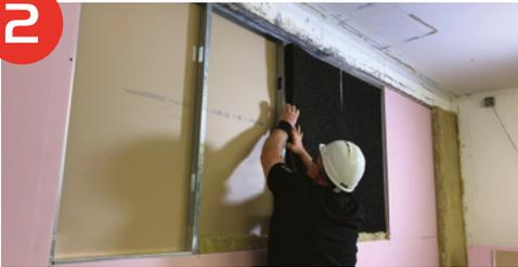
**FZ100** wird zwischen zwei vertikalen Stützen in den gewünschten Einsatzbereich gedrückt (z. B. über dem Türsturz).
