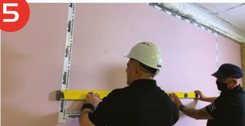
Markieren Sie Ihre geplanten Positionen der Leitungsdurchführung innerhalb der gekennzeichneten **FZ100**-Zone (bitte stellen Sie sicher, dass Sie den Bereich aussparen, in dem sich die Trockenbauprofile befinden).
