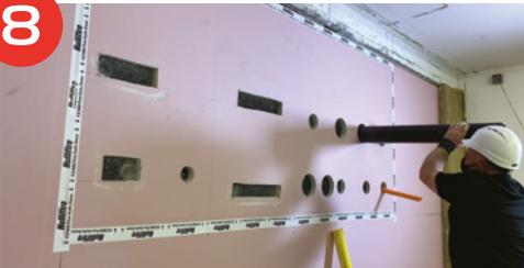
Nach dem Schneiden schieben Sie FZ100 vorsichtig in den Hohlraum zurück, um die gewünschte Öffnung freizulegen, und führen die gewünschten Durchführungen durch die nun freigelegte Öffnung (FZ100 wird mit der Zeit seine ursprüngliche Form um die Durchführung herum annehmen).
