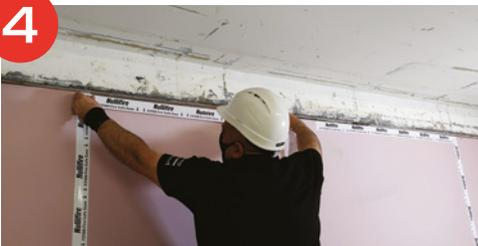
Markieren Sie den Bereich der „Fire Safe Zone“ mit dem selbstklebenden Nullifire **FZ100**-Kennzeichnungsband.
