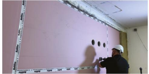
Für quadratische oder rechteckige Durchführungen bohren Sie direkt durch die Trennwand an den vier Ecken der gewünschten Durchführung. Die Trockenbauplatten können nun auf jeder Seite einzeln ausgeschnitten werden, ohne die FZ100-Füllung zu entfernen.
