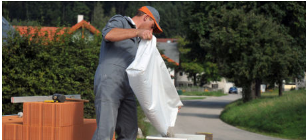
Das Granulat wird in die Hohlkammern des Ziegels eingefüllt!
