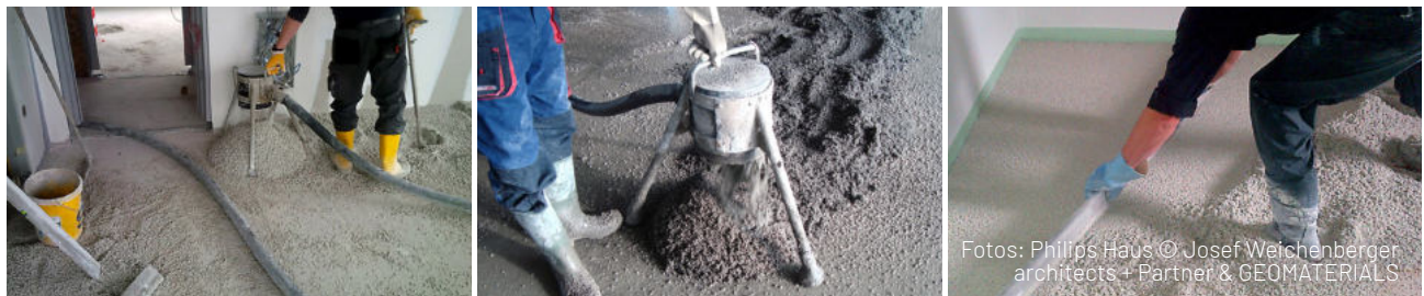
Fördern und Einbringen mit der Estrichpumpe
