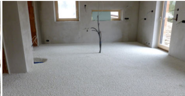
4. Schritt - fertig eingebaut alle Installationsleitungen sind fugenlos umhüllt und somit isoliert
