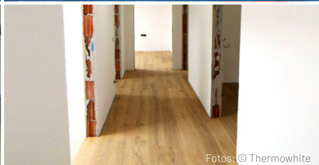
8. Schritt - Bodenverlegung abschließend wird der gewünschte Fussboden gelegt
