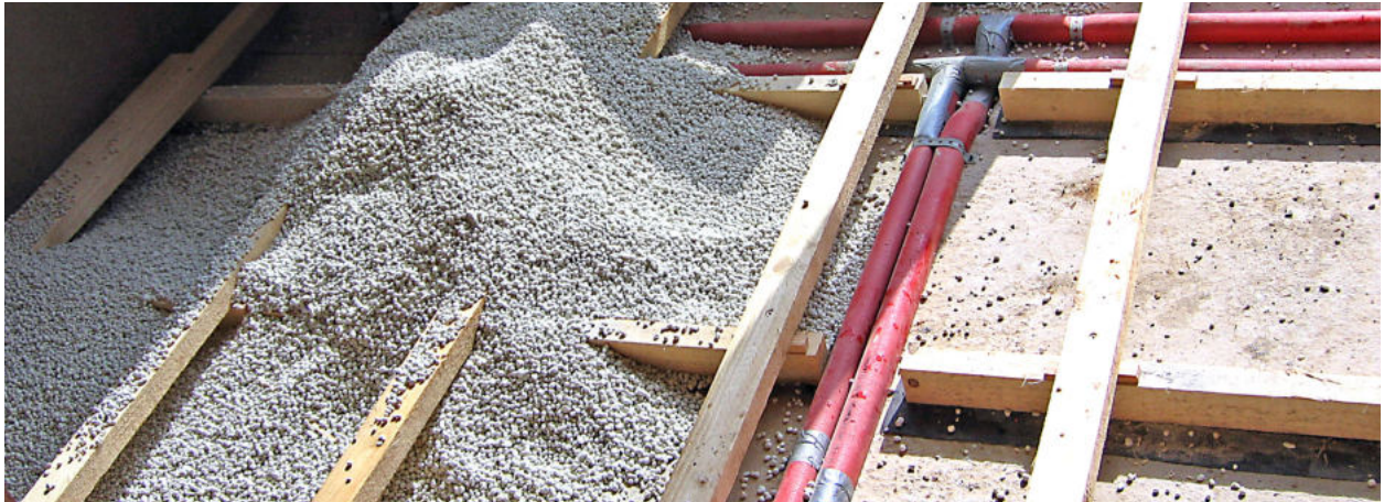
Ausgleichsschüttung zwischen Polsterhölzer
