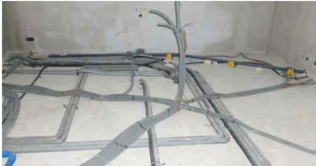
1. Schritt - Rohinstallation Abgeschlossene Installationsarbeiten vor der Wärmedämmung
