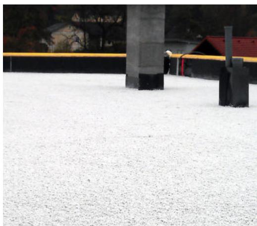
Unproblematisches Einbinden von Dachdurchdringungen
