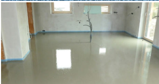
7. Schritt - Estrich wird laut Waagriss, auf das gewünschte Niveau eingebaut
