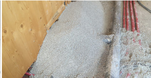
2. Schritt GEOMATERIALS Blähglas überdeckt alle Installationsleitungen
