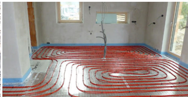
6. Schritt - Verlegung Fussbodenheizung Nach der Austrocknungszeit von mind. 48 Stunden
