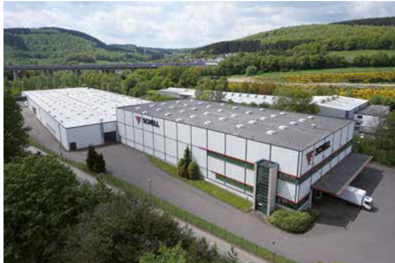
Werk 2 Produktion mit Logistikzentrum
