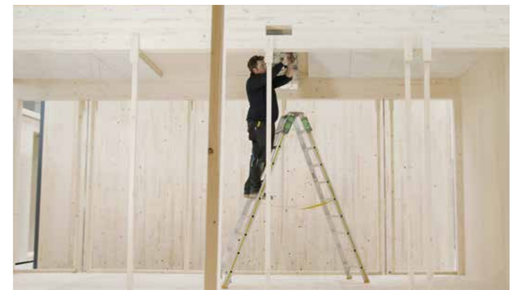
Installation der technischen Gebäudeausrüstung.
