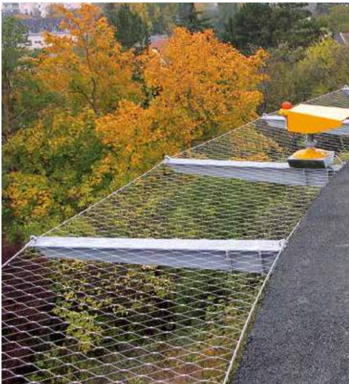
Stehende Masche_Vertical mesh diamond direction
