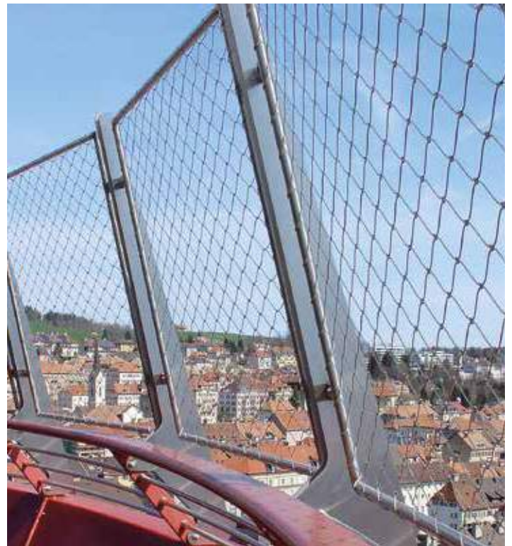
Liegende Masche_Horizontal mesh diamond direction
