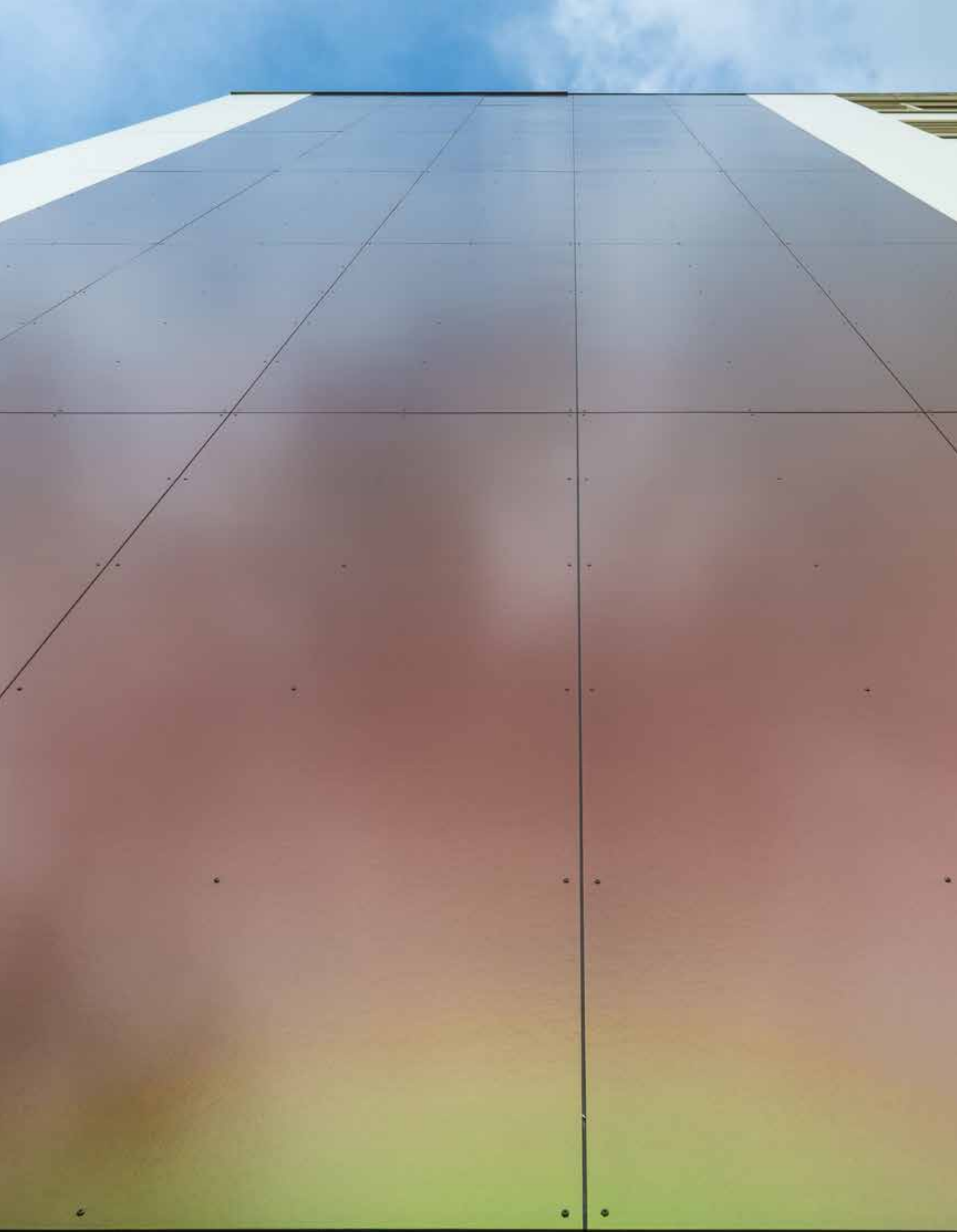
Renovierungsprojekt Mehrfamilienhaus, Haarlem, Niederlande
