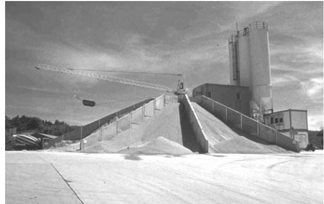
Bild 2: Vorbildlich ausgestaltete Mischanlage
