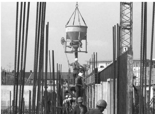
Bild 3: Fördern des Betons mit dem Kübel
