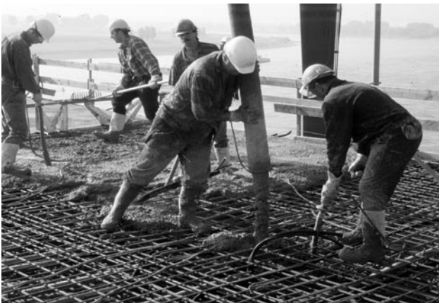
Bild 1: Verarbeiten von Beton auf der Baustelle
