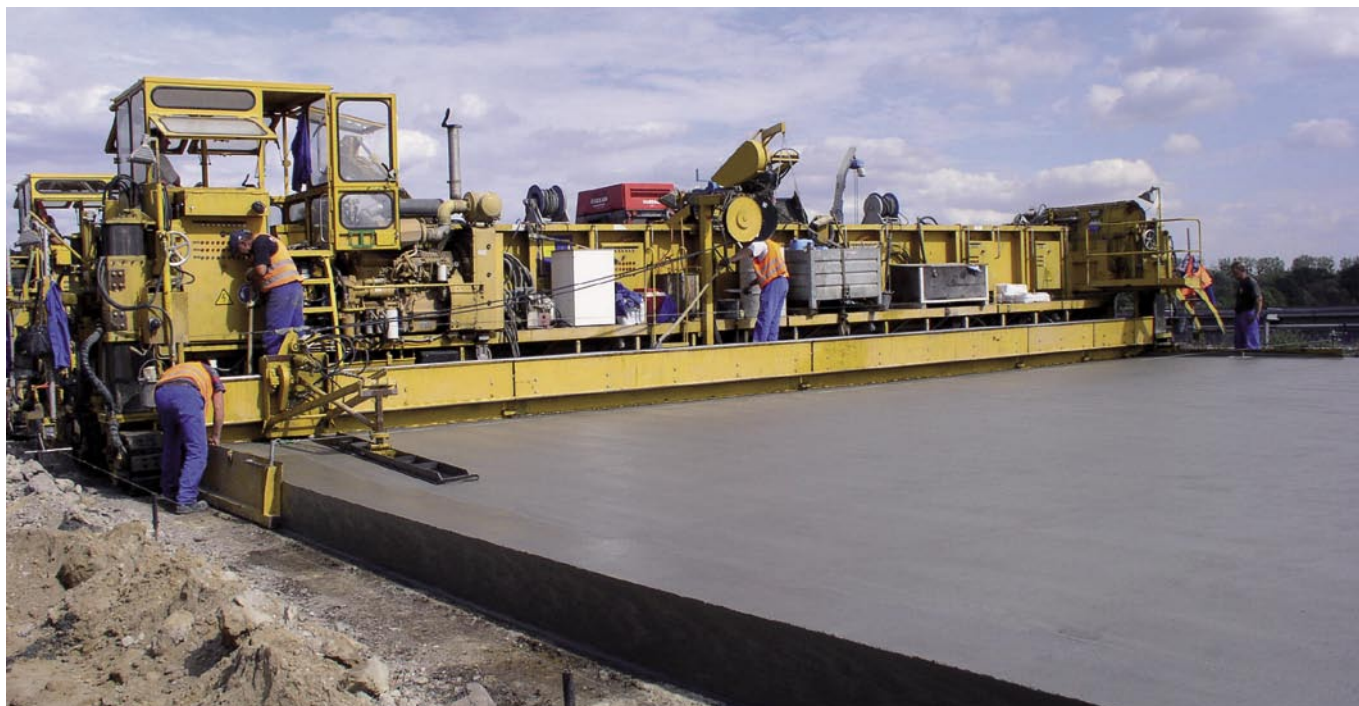
Bild 4: Glätten der fertig eingebauten Betondecke
