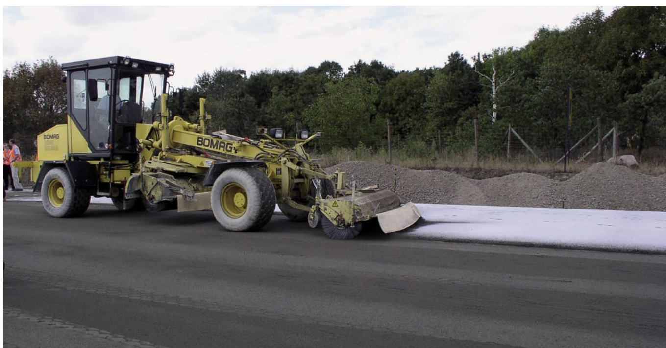
Bild 5: Ausbürsten des Oberflächenmörtels im Nassverfahren
