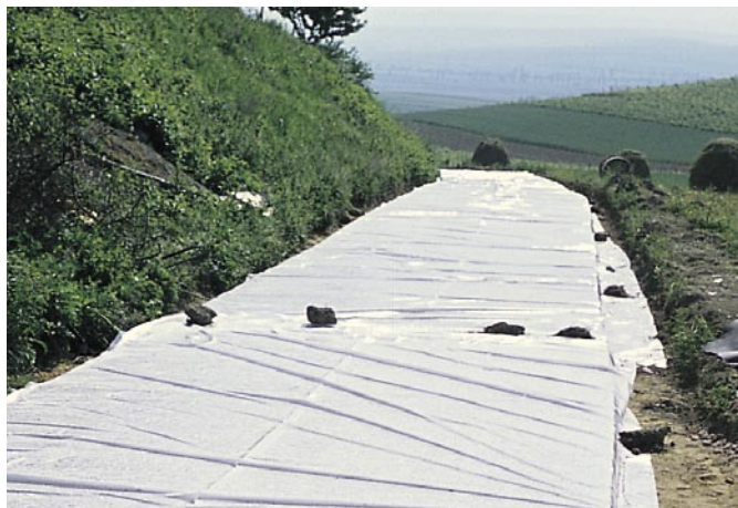
Bild 8: Nachbehandlung der Betondecke durch Abdecken mit Folien
