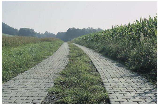
Bild 15: Spurweg aus Betonpflastersteinen mit Verbund
