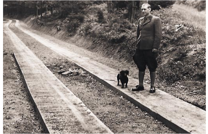
Bild 10: Spurwegebau vor 50 Jahren
