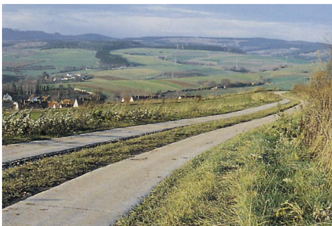
Bild 9: Spurweg mit Betonspuren aus Ortbeton
