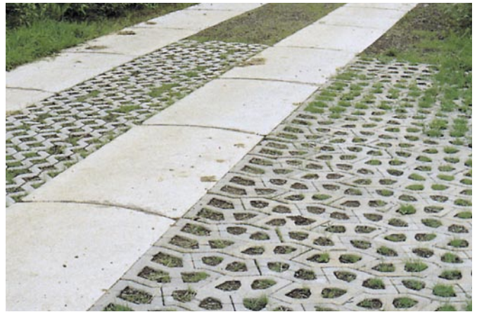
Bild 14: Weg mit Spurplatten, Abzweig mit Rasengitter- und Rasenverbundsteinen befestigt
