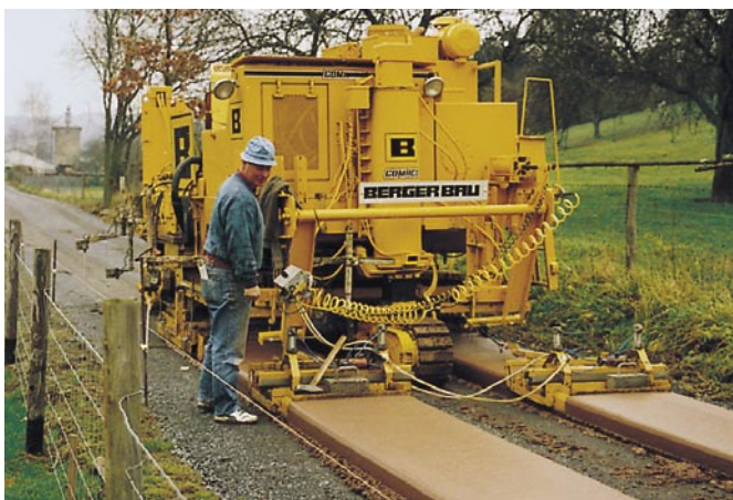
Bild 13: Einbau von Betonspuren mit einem Gleitschalungsfertiger
