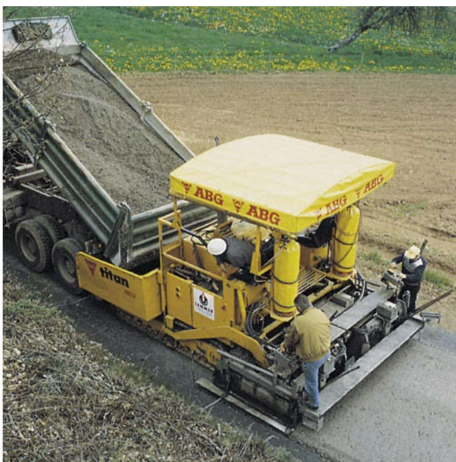
Bild 8: Einbau einer HGTD mit einem Straßenfertiger
