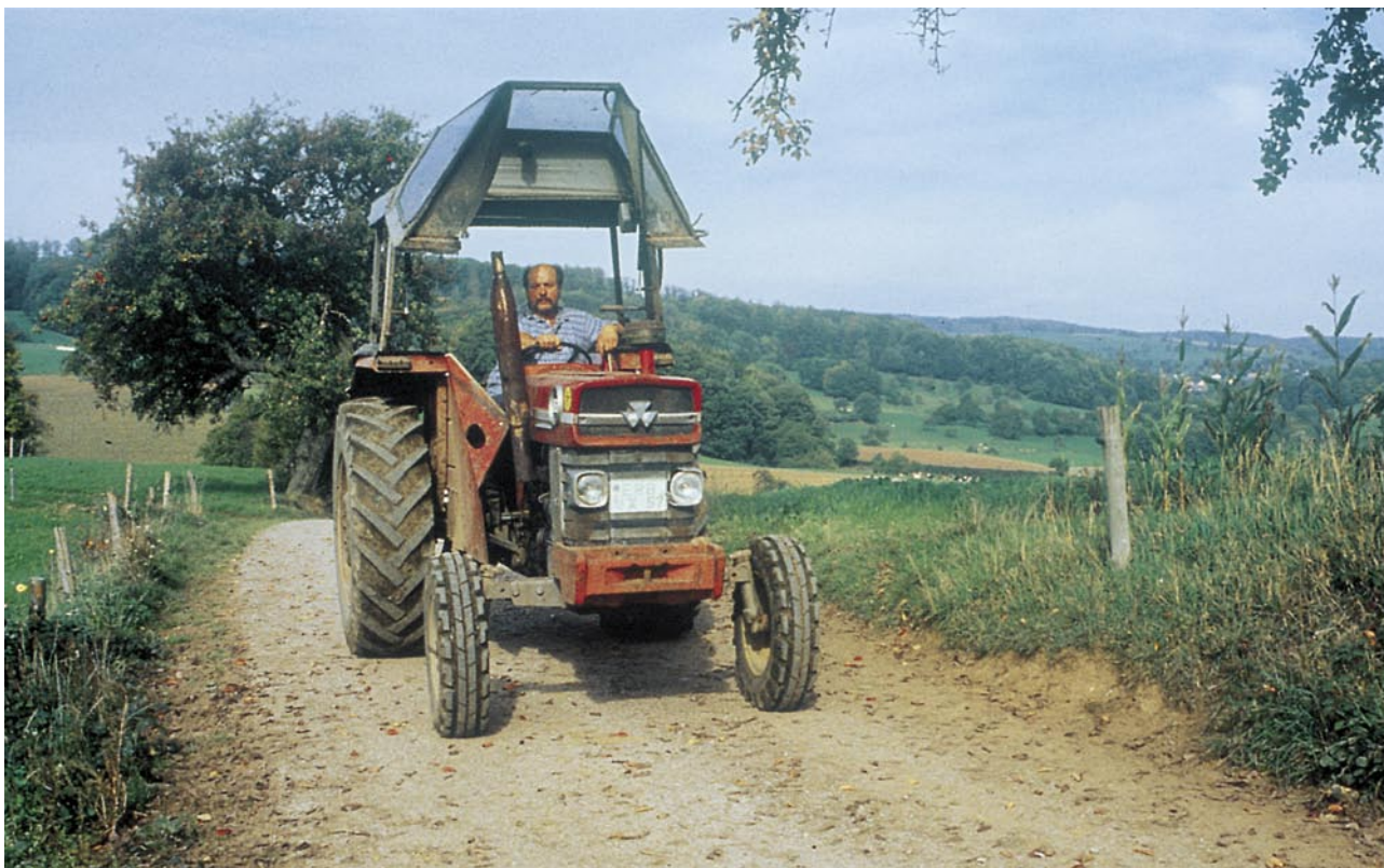
Bild 1: Naturnaher Weg mit hydraulisch gebundener Tragdeckschicht (HGTD)
