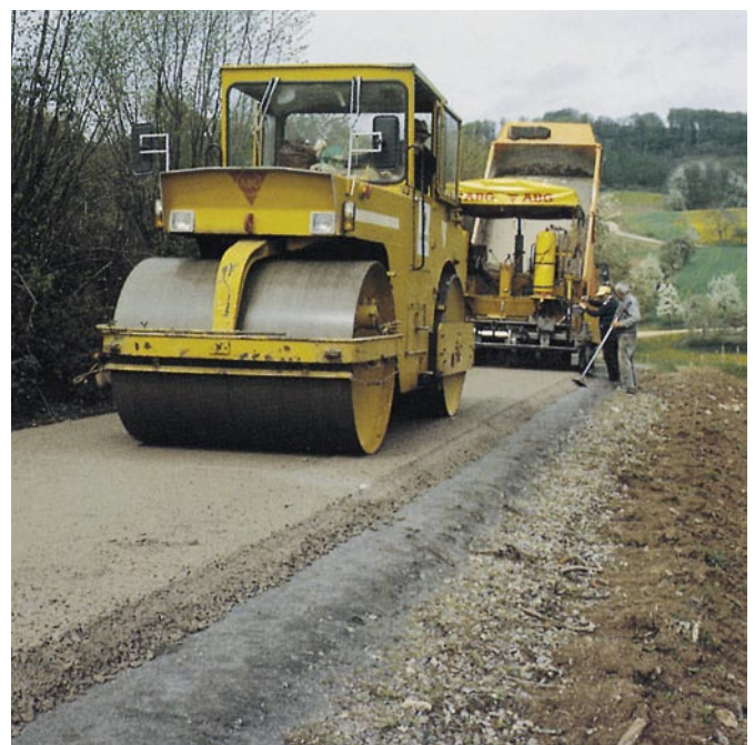
Bild 9: Walzen einer HGTD
