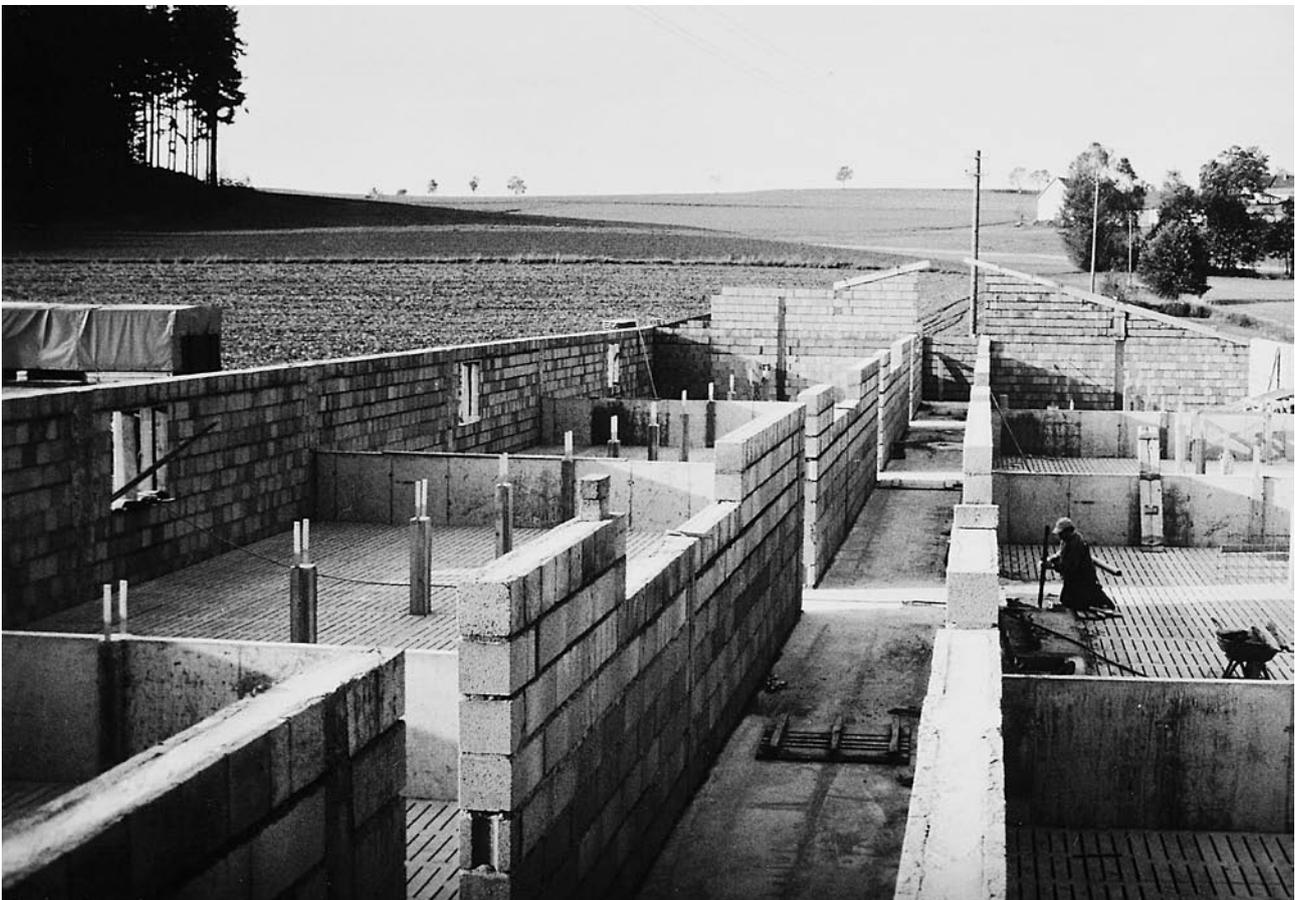
Bild 1: Schweinestall im Bau mit Außenwänden aus Leichtbetonsteinen
