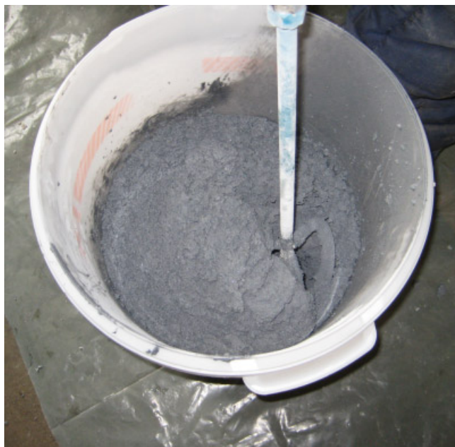
Gemischtes Material "umtopfen", um Mischfehler in Gebinderandbereichen zu vermeiden. Wenn notwendig nachmischen.
