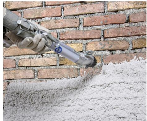
PCI Saniment 2 in 1 ist sowohl manuell als auch maschinell leicht verarbeitbar.
