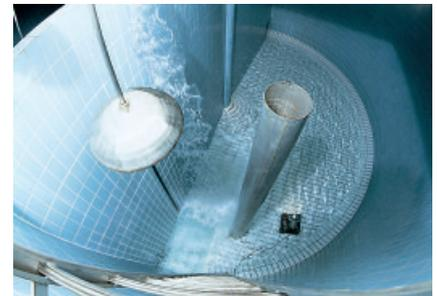
Mit PCI Silcoferm KTW ausgebildete Anschluss- und Bewegungsfugen im Trinkwasserbehälter.
