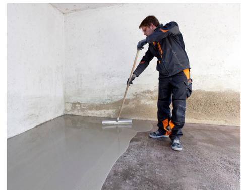
Vollflächiger Bodenausgleich mit leicht verlaufendem PCI Zemtec<sup>®</sup> Outdoor für direkte Nutzbarkeit.
