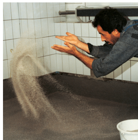
... und Quarzsand (Körnung 0,3 bis 0,8 mm) in die frische Beschichtung eingestreut.
