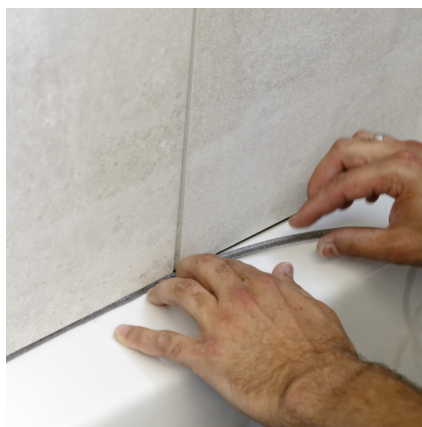
Rundschnur einlegen und anschließend Silikonfuge anbringen.
