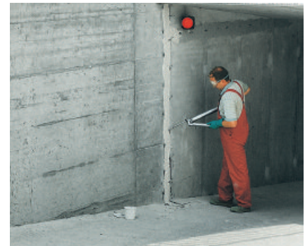
Mit PCI Apogel PU werden wasserführende Risse schnell abgedichtet.
