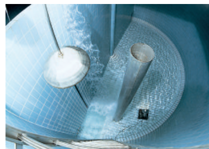
Mit PCI Silcoferm KTW ausgebildete Anschluss- und Bewegungsfugen im Trinkwasserbehälter. Werksfoto: Buchtal
