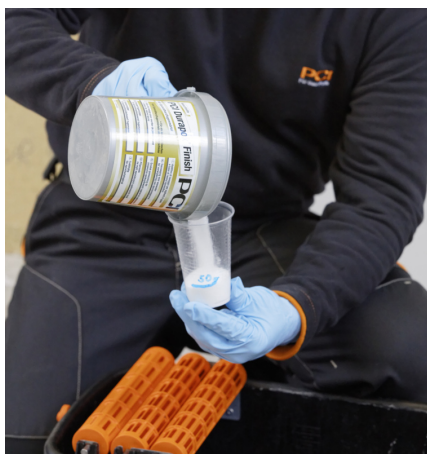
Alternativ kann auch PCI Durapox Finish (Konzentrat) MV 1:100; 5l Wasser: 50 g Durapox Finish; direkt in das Waschwasser hinzugegeben werden.
