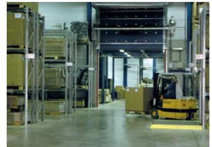
Hochabriebfeste Flächen unter Verwendung von PCI Repatop 800 hergestellt.
