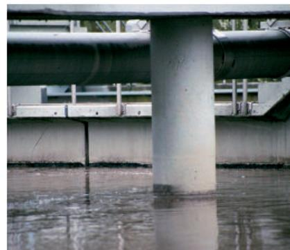
Sicheres Schließen von horizontalen und vertikalen Anschluss- und Bewegungsfugen in einer Kläranlage mit PCI Escutan TF.
