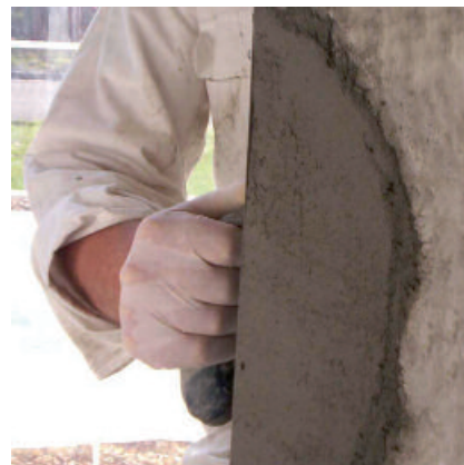
Instandsetzung von Ecken und Kanten - nur eine der vielen Einsatzmöglichkeiten des universellen Reparaturmörtels PCI Nanocret R2.
