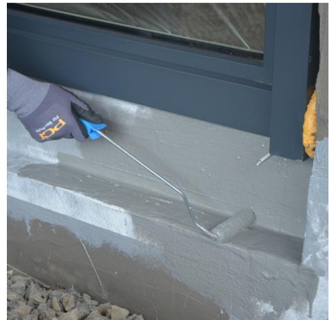
Das eingelegte PCI Barraseal Ready Vlies frisch mit einer zweiten Lage PCI Barraseal Ready vollständig überarbeiten.
