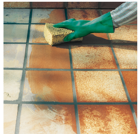
... und anschließend mit einem feuchten Schwamm nachwaschen.
