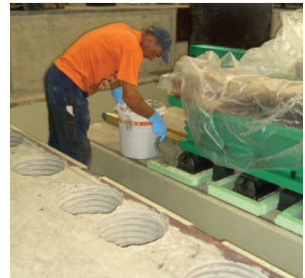
Verguss einer Maschinenverankerung mit PCI Repaflow Plus
