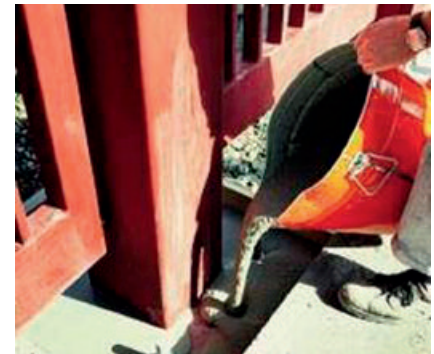
Mit PCI Repaflow Uni werden kraftschlüssige Verbindungen hergestellt.
