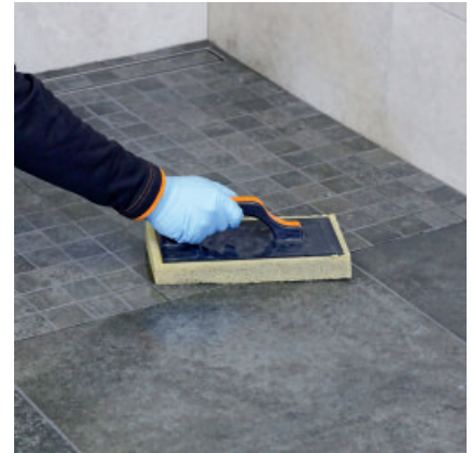
Finaler Waschgang: Abreinigen der Fläche mit dem Schwammbrett
