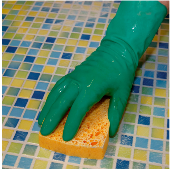
Waschen der verfugten Beläge mit PCI Epoxi-Schwamm fein.
