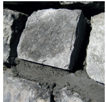
Pavifix CEM ROC in steifplastischer Konsistenz zum Setzen und Verfugen von Naturwerksteinen
