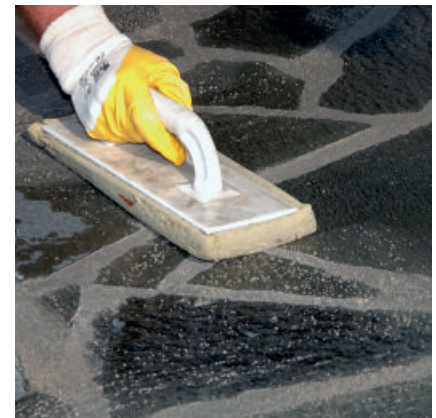
Innerhalb 1 Stunde Plattenbelag mit dem Schwammbrett nachwaschen.
