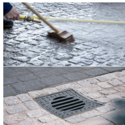
Beim Schlämmverfahren lässt sich PCI Pavifix CEM leicht mit einem Gummischieber in die Fugen einbringen.
