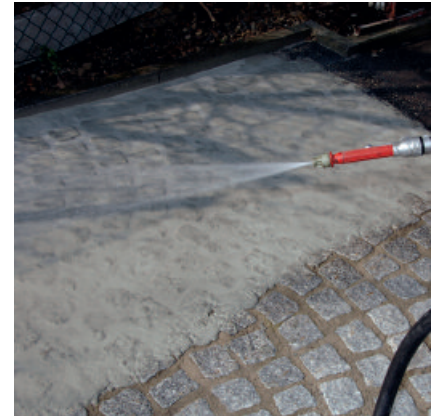
Um beim Reinigen der Pflastersteine ein Ausspülen der Fugen zu vermeiden, ist der Wasserstrahl nahezu horizontal zur Oberfläche zu halten.
