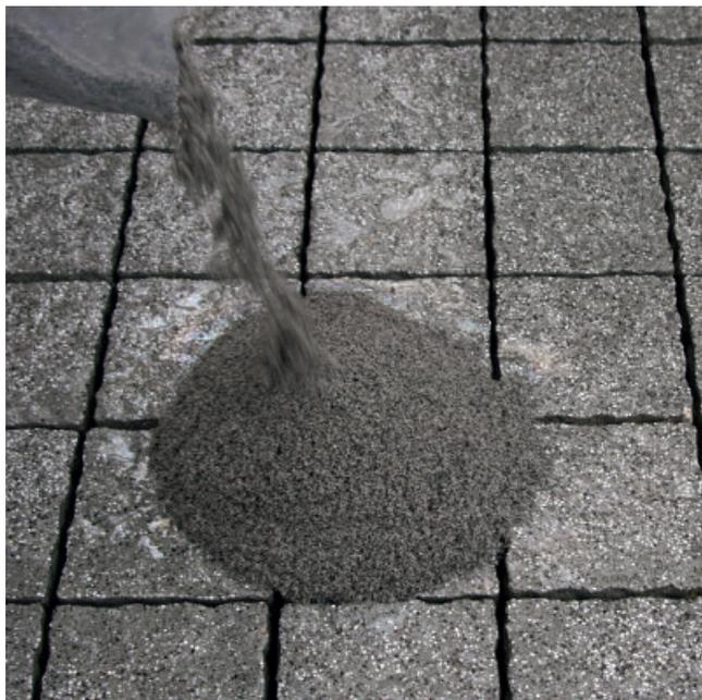
Vakuumbutel aufschneiden und frisches Material auf die nasse Belags-
