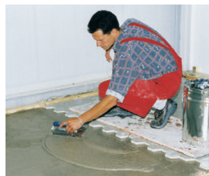
Der ausgegossene Verlegemörtel kann mit einer Zahnkelle leicht verteilt werden.
