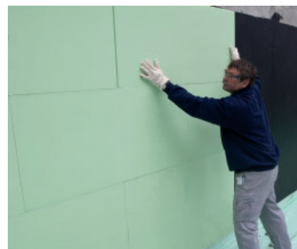
Einschieben der Styrodur ® Perimeterdämmplatten in das Kleberbett aus PCI Pecimor DK.
