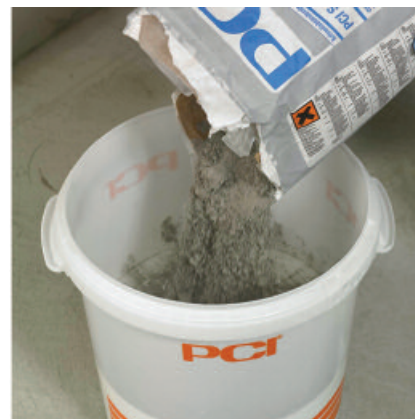
PCI Seccoral 2K Rapid Pulver dazugeben.
