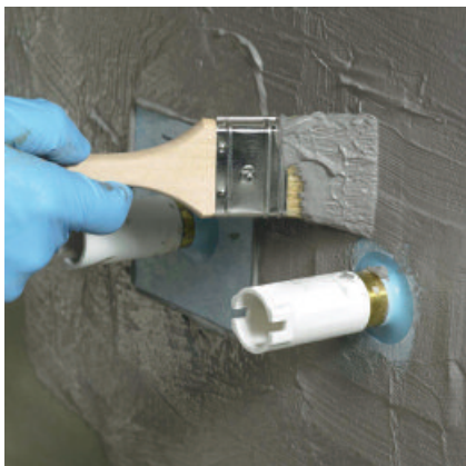
Die Dichtmanschetten PCI Pecitape 10 x 10 ordnungsgemäß einbetten.
