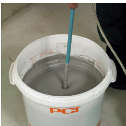
PCI Seccoral 2K Rapid für das Spachtelverfahren (1 a) zu einer homogenen Masse anmischen.
